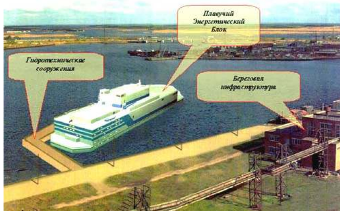
Рис. 25. Плавучая энергетическая установка с двумя ядерными реакторами КЛТ-40С [26]
